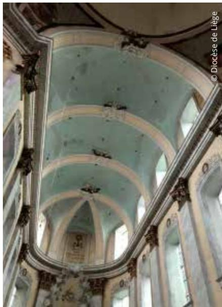
Les dégâts provoqués par les infiltrations d'eau sont nettement visibles.
